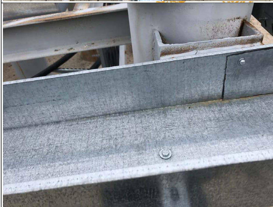
Фото.№2. Лоток листовой 200х100. Площадка КТПМ, отходящая кабельная эстакада.
