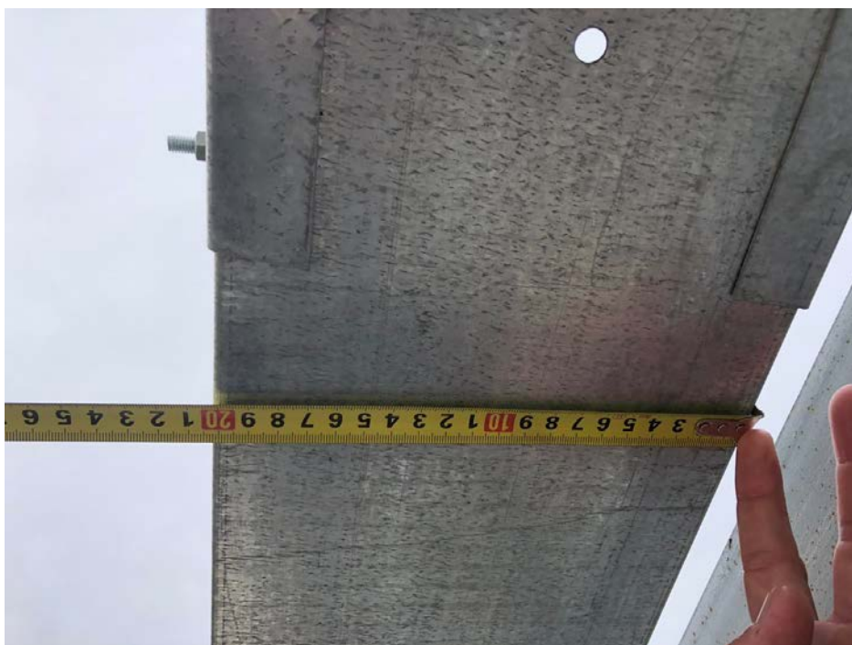
Рис.4. Измерение размеров (200 мм) листового штампованного лотка. Площадка КТПМ отходящая кабельная эстакада.
