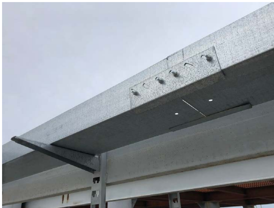
Рис.7. Фактически смонтированный металлический штампованный лоток, вместо необходимого «лотка листового штампованного 300x160 L6000 сталь 2мм WKSГ 163 FT для больших расстояний ОВО».
