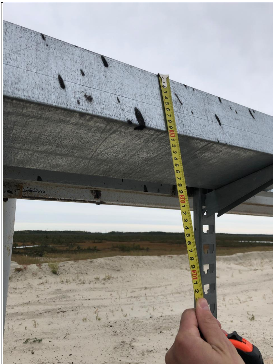
Фото №18. Лоток листовой 200х100. Отпайка от кабельной эстакады до АГЗУ-1.
