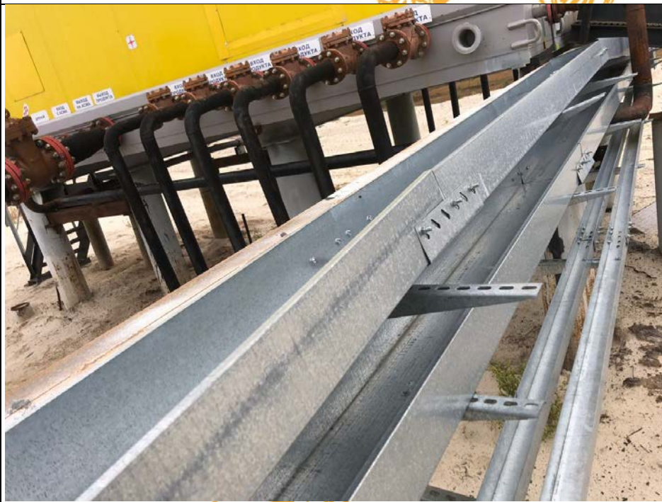
Фото №16. Лоток листовой 200х100. Отпайка от кабельной эстакады до АГЗУ-1.
