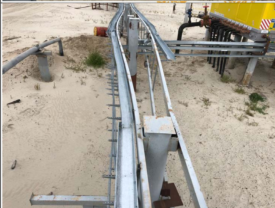
Фото №20. Лоток листовой 200х100. Кабельная эстакада в р-не скважины № 1.
