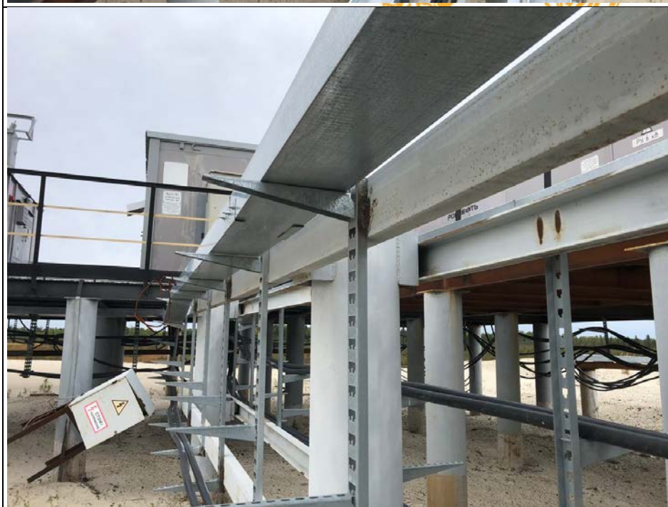
Фото №4. Лоток листовой 200х100. Площадка КТПМ, отходящая кабельная эстакада.
