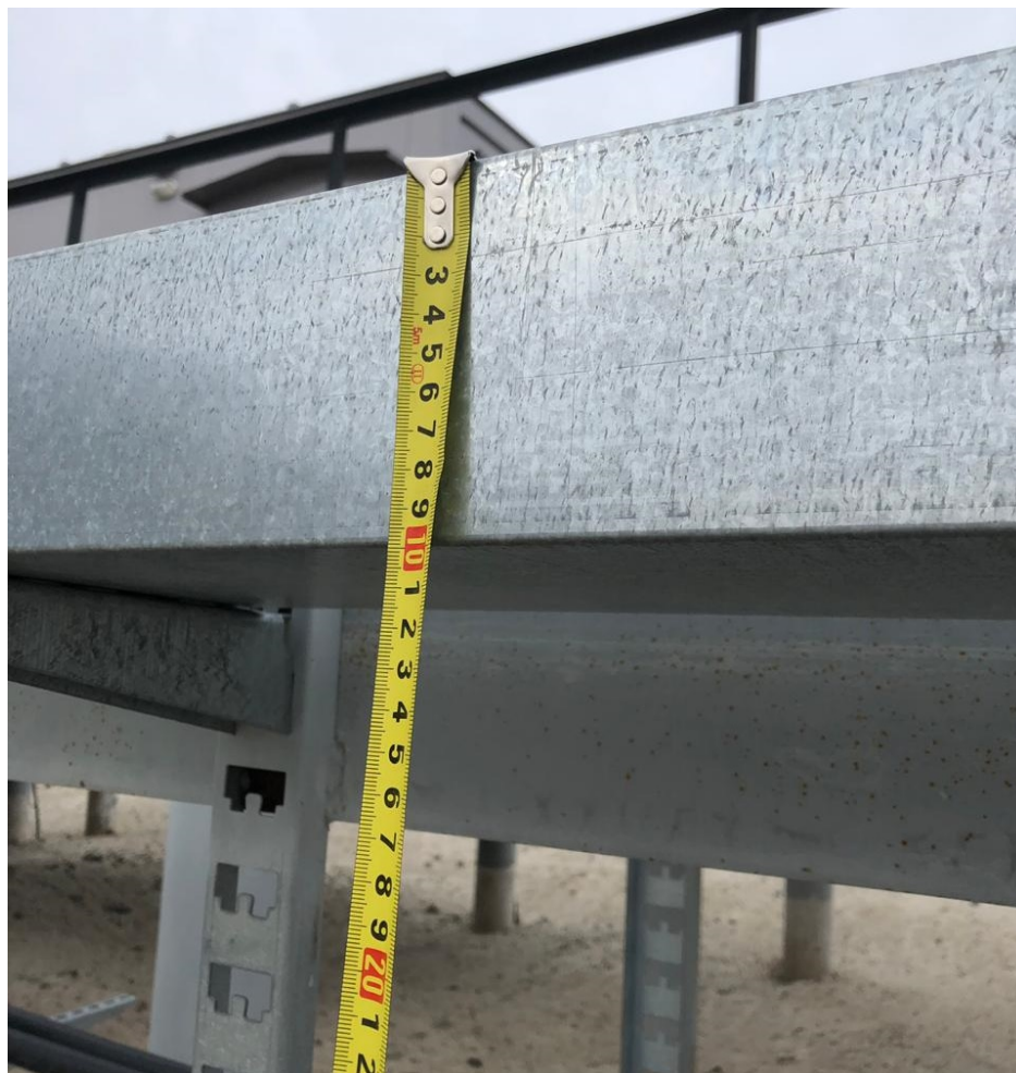
Рис.5. Измерение размеров (100 мм) листового штампованного лотка. Площадка КТПМ отходящая кабельная эстакада.
