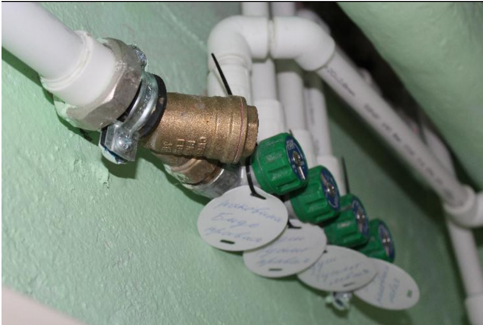
Фото №33. Гребёнка распределения ХВС и сетчатый фильтр.
