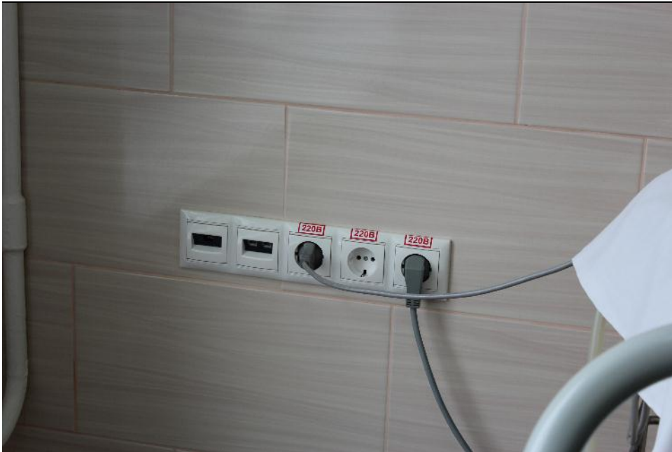
Фото№27. Смонтированный розеточный блок с выходами на телефонизацию и интернет.
