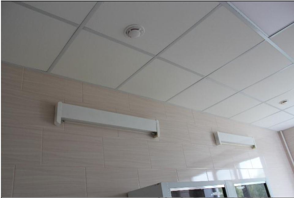
Фото№24. Смонтированные бактерицидные облучатели.
