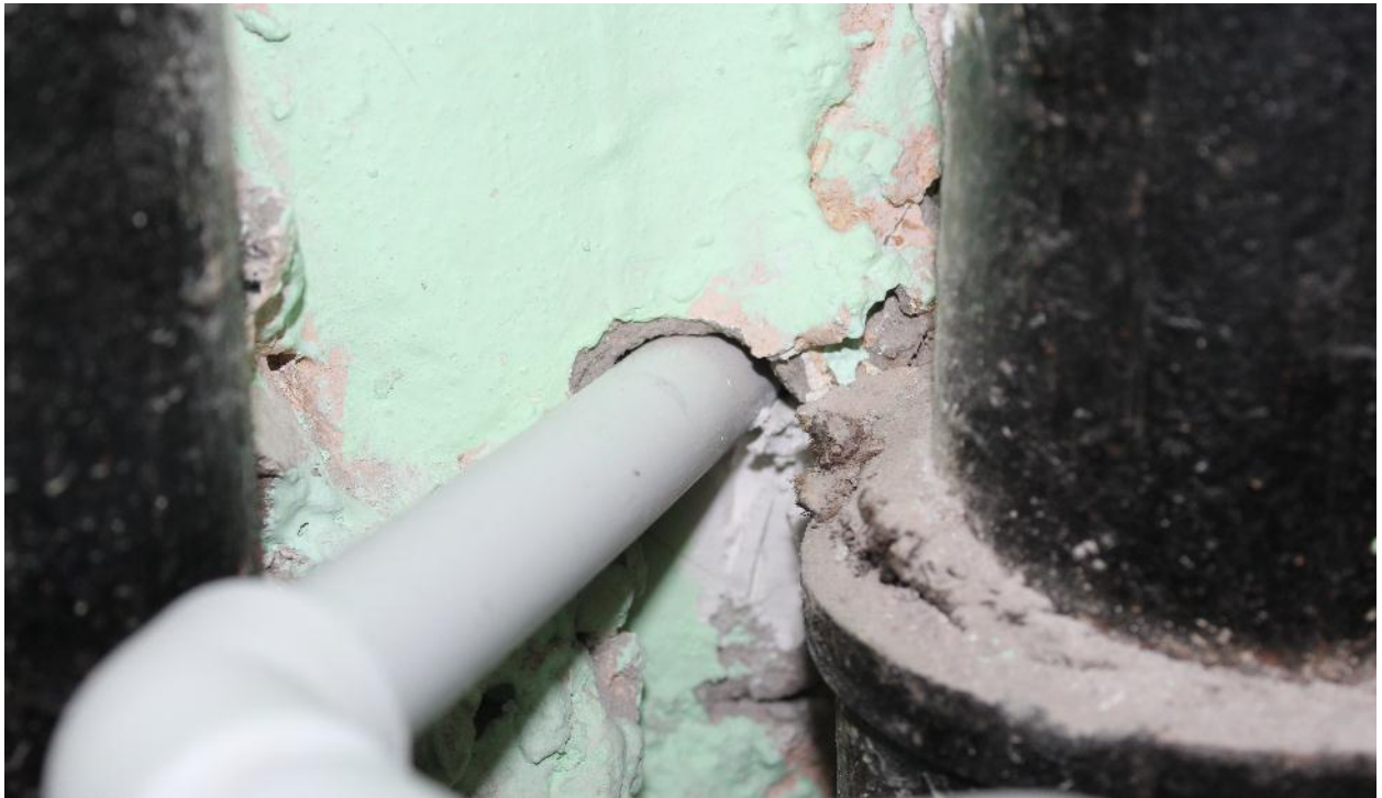
Рис. № 6. Примыкание трубопровода к строительным конструкциям.
