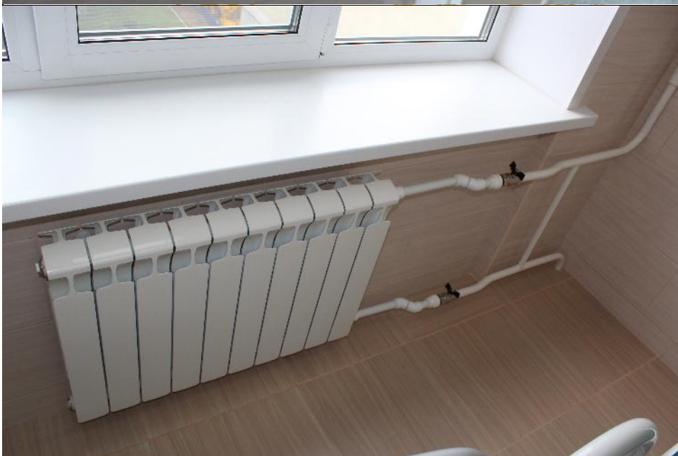
Фото№26. Смонтированный радиатор.
